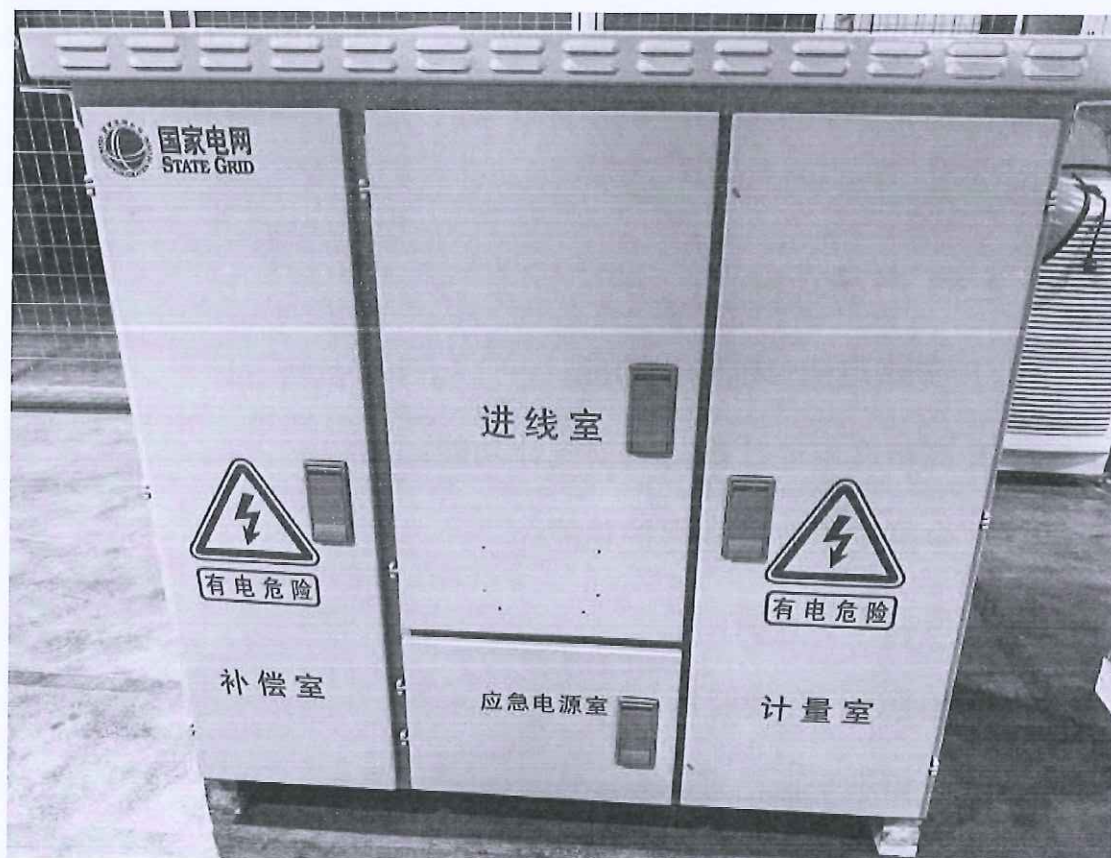
低压综合配电箱 (JP)
