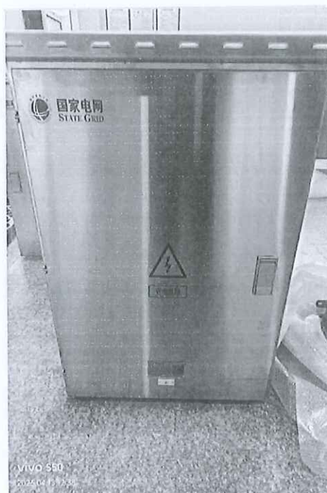
低压电缆分支箱（TFDF）
