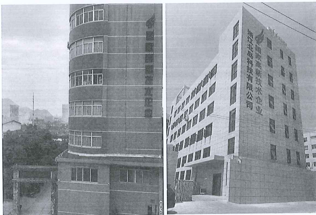
浙江省温州市乐清市柳市镇东风工业区腾飞路22号 浙江省温州市乐清市柳市镇东风工业区腾飞路17号
