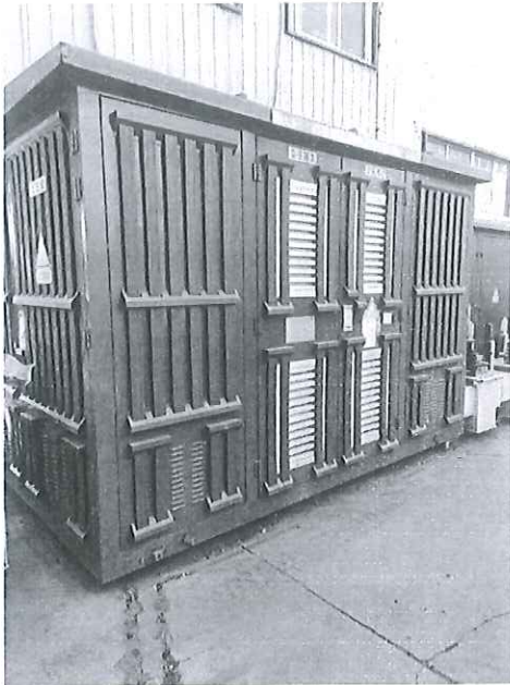
高压/低压预装式变电站
