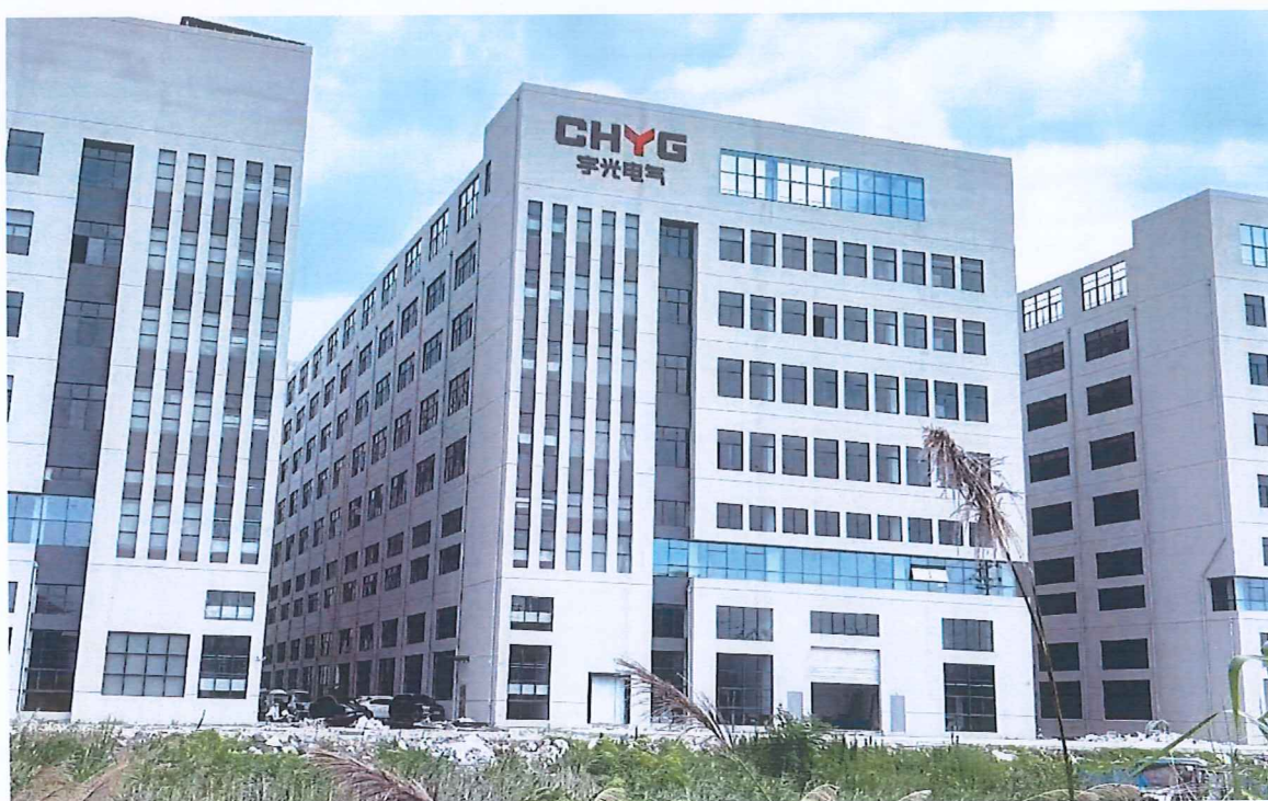
浙江省温州市乐清市乐清湾临港经开区里虹大道 1 号高新产业园 12 幢概貌
